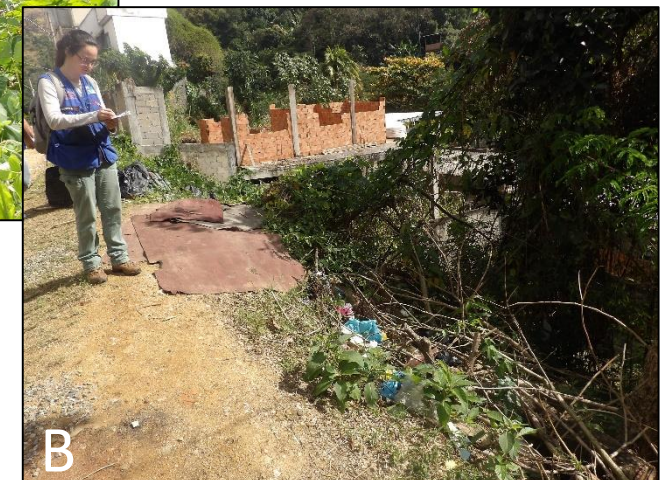
(A) Encosta natural aos fundos das residências nº1601 e nº1591 da Avenida Brasil, com vegetação rasteira inclinação de 50°, (B) Perfil de aterro no topo do talude, executado para viabilizar o traçado da Rua José Dias Guimarães.
