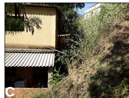
(A) Cicatriz de escorregamento pretérito a montante da casa nº 1427 da Av. Brasil, notar barreira na lateral da rua para evitar o escoamento de água diretamente nos taludes de corte a jusante da rua José Dias Guimarães. (B) Obra realizada de forma rudimentar para conter escorregamento no talude de corte nos fundos da casa 1427. (C) Talude de corte sem tratamento, colado nos fundos da casa 1437. (D) Talude com material presente inconsolidado: solo, entulho e lixo nos fundos da casa 1437.
