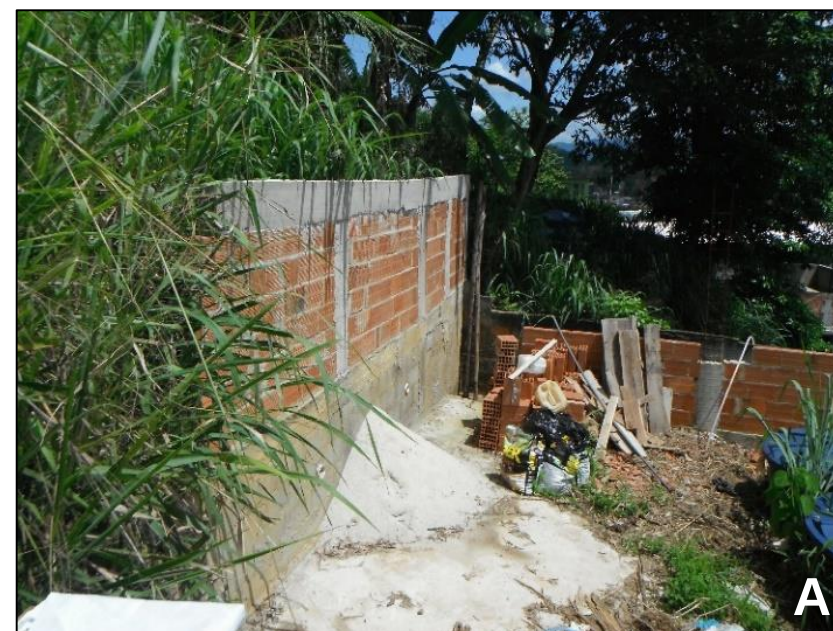
(A) Muro simples de alvenaria, com a base em blocos estruturais e barbacãs.
