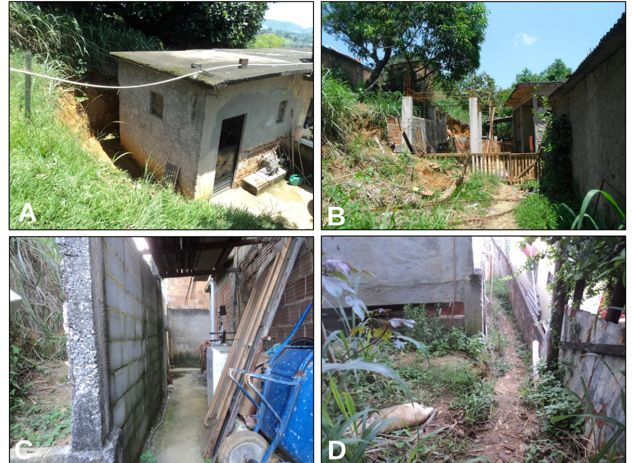
(A) Residência nº 72 próxima ao talude de corte. (B) Obra de extensão da residência nº 70, aproximando a casa ao talude de corte. (C) Muro de blocos nos fundos da residência nº 65. (D) Vista a montante do talude de corte evidenciando sua altura e alta inclinação.
