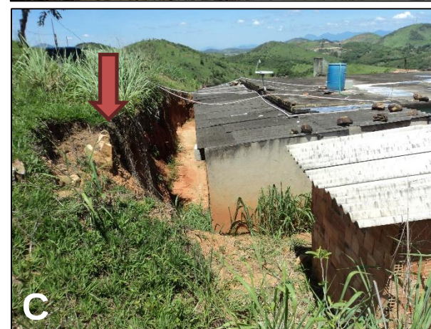
(A) Distância entre o talude e a moradia. (B) Trincas sobre o talude. (C) Bloco rochoso dentro do solo residual. (D) Descarte inadequado de água na encosta.
