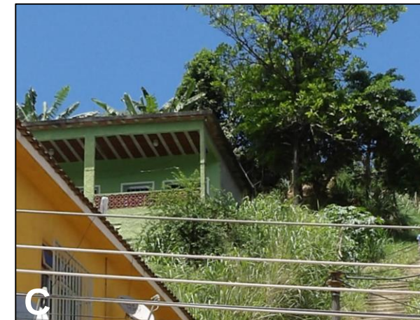
(A) Vista da lateral da residência sob risco muito alto; (B) Área a montante da residência com presença de bananeiras e mamões; (C) Vista frontal da residência.
