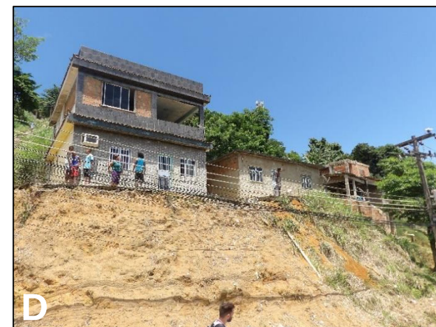
(A) Fundos de moradia a jusante da Rua Guaira. (B) Talude de corte com histórico de escorregamento (C) Talude de corte aos fundos de moradia, típico da área. (D) Talude de corte entre a Rua Solimões e moradias.
