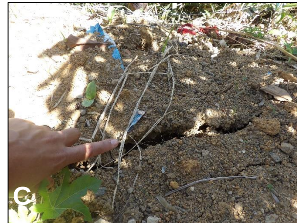
(A) Moradia na Rua Itapoã, despejando água servida no aterro. (B) Vista a partir do aterro sobre a casa abandonada com a cerca inclinada. (C) Trinca no aterro. (D) Vista da encosta a montante da casa abandonada.
