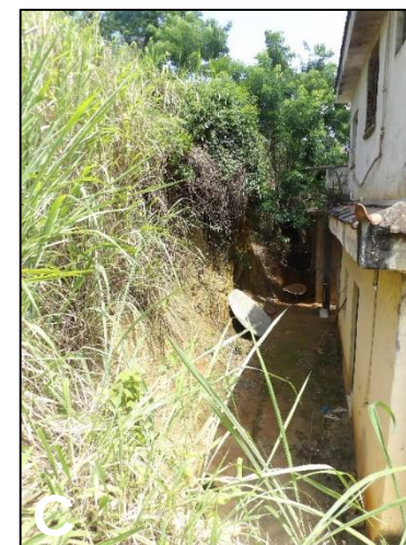
(A) Fundos de moradia a jusante da Rua Guaira. (B) Talude de corte com histórico de escorregamento (C) Talude de corte aos fundos de moradia, típico da área. (D) Talude de corte entre a Rua Solimões e moradias.
