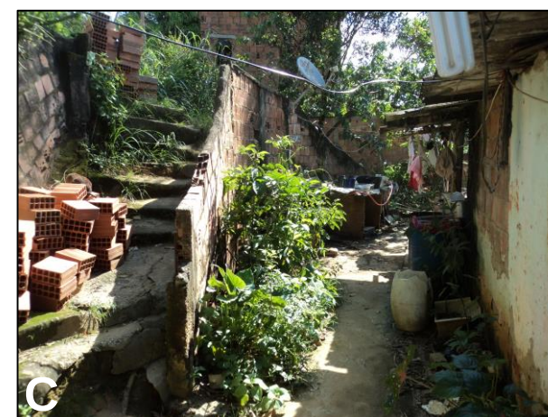
(A) Proximidade da residência à base do talude de corte. (B) Acúmulo de lixo e entulho nos terrenos. (C) Muro de alvenaria tortuoso e sem drenos. (D) Esgoto lançado diretamente sobre o terreno.
