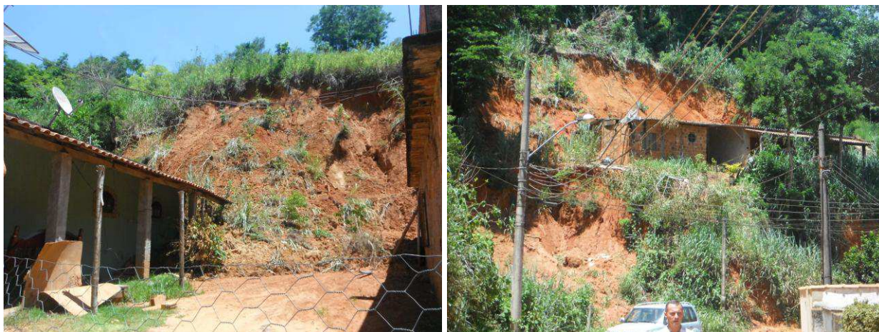
Figura 1: Deslizamentos planares afetando taludes no bairro Ponte.
