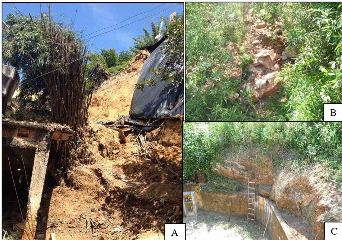
**Figura 1.** Rua Almir Alves de Souza: A- Vista da moradia a jusante com parte da varanda destruída devido ao escorregamento, e na Rua Custódio de Oliveira: B - a base da encosta com rocha alterada fraturada, e C - blocos individualizados após deslizamento.
