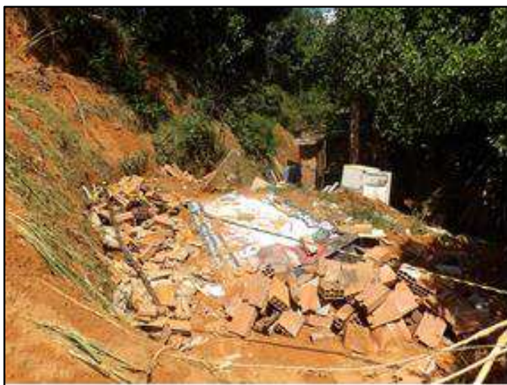
Foto 3 - Área afetada pelo escorregamento ocorrido em 21/01/17, escombros da residência destruída.
