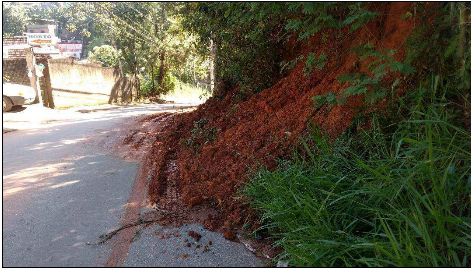
Foto 1 - Escorregamento a beira da via. Fonte: Defesa Civil de Nova Friburgo.
