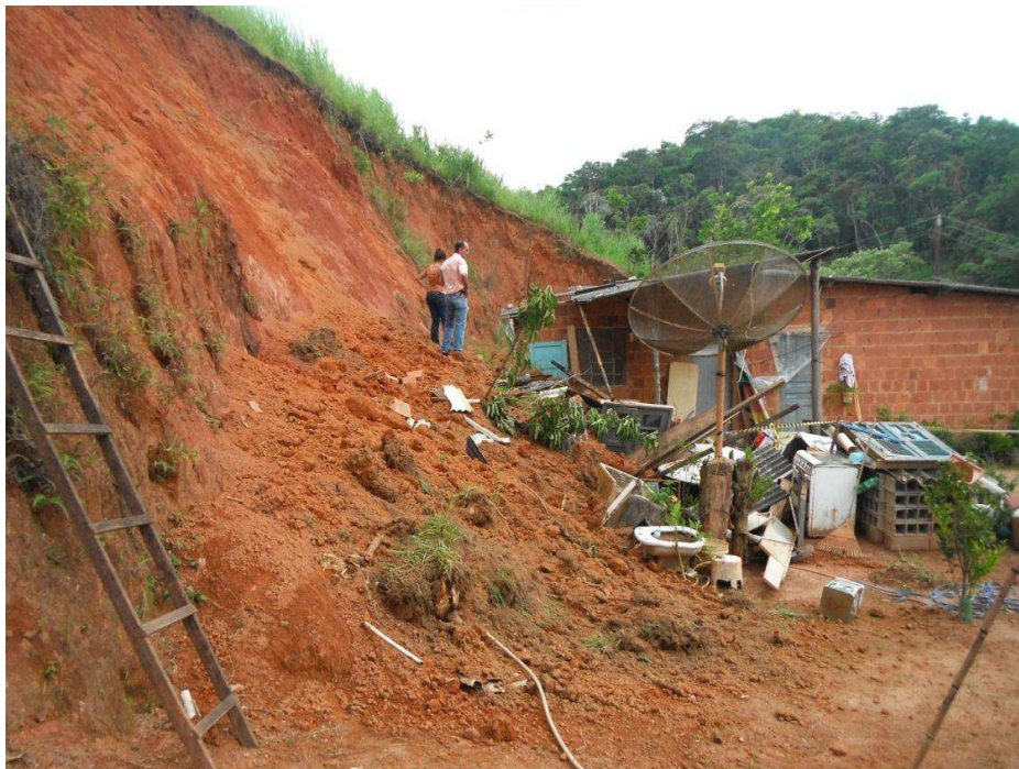
Foto 3: Vista lateral do deslizamento que causou uma morte em Mendes
