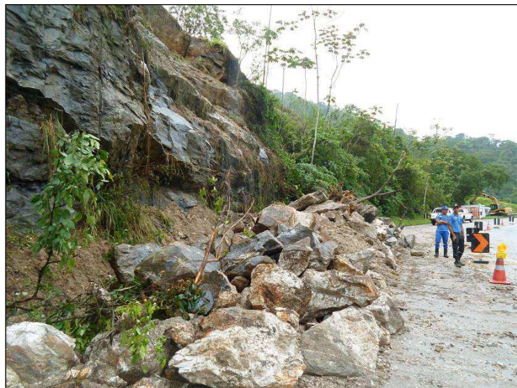
Figura 1: Queda de blocos no km 106 na BR-116, no município de Guapimirim.
