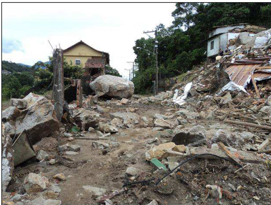
Figura 3: Depósito do material mobilizado na Rua Uruguai.
