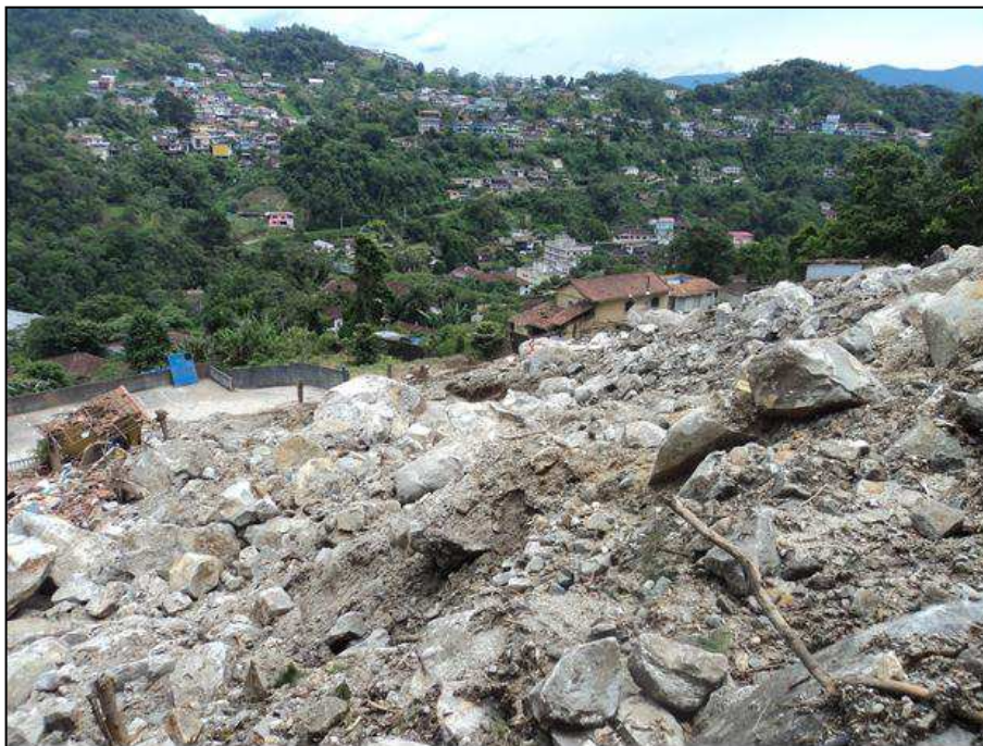
Figura 1: Vista de montante do escorregamento ocorrido no dia 14/11.
