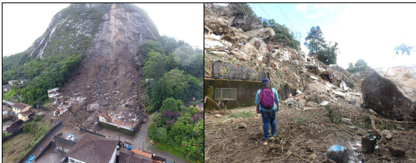
Figura 1 - Acidente ocorrido na noite do dia 14/11 no bairro Quitandinha (imagem cedida pela DC de Petrópolis), e material mobilizado que destruiu três residências na rua Uruguai vitimando duas pessoas.
