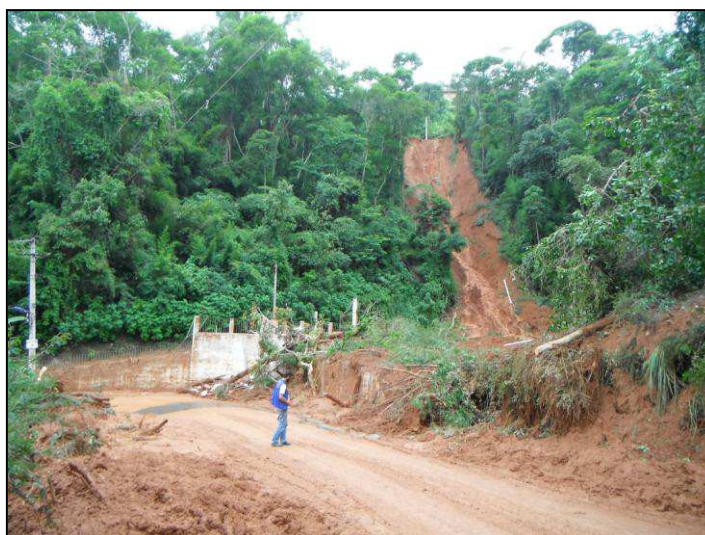
Figura 2: Deslizamento que destruiu o posto de saúde no bairro Granja Florestal no município de Teresópolis.
