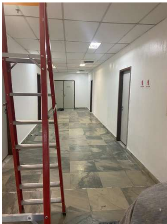
Troca de Forros e Luminárias
