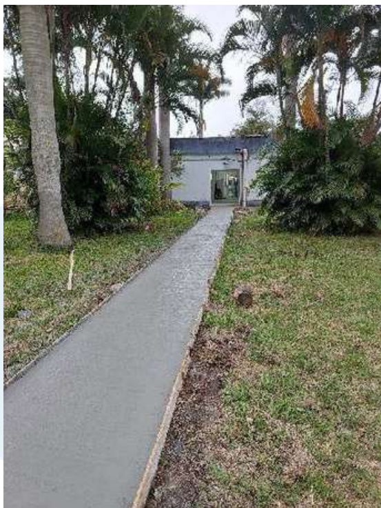
Concretagem dos acessos externos ao prédio principal
