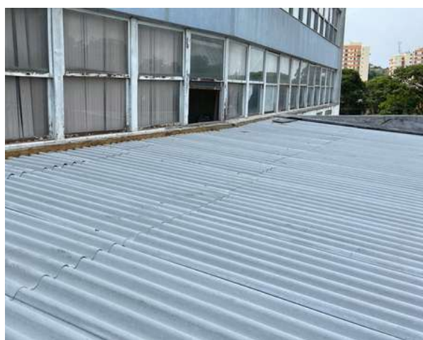
Troca de telhas
