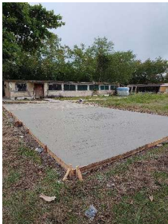
Concretagem externa do estacionamento para veículos
