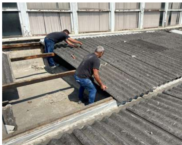
Troca de telhas
