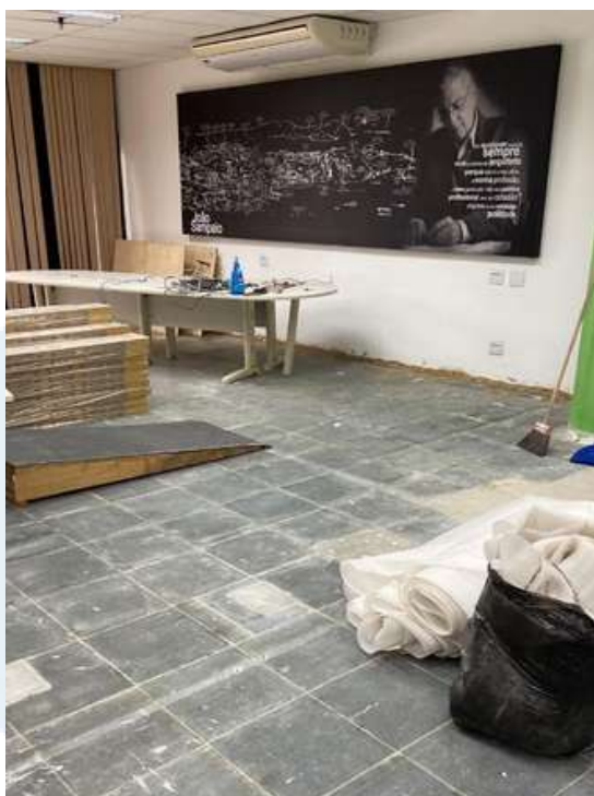
Reforma do Auditório
