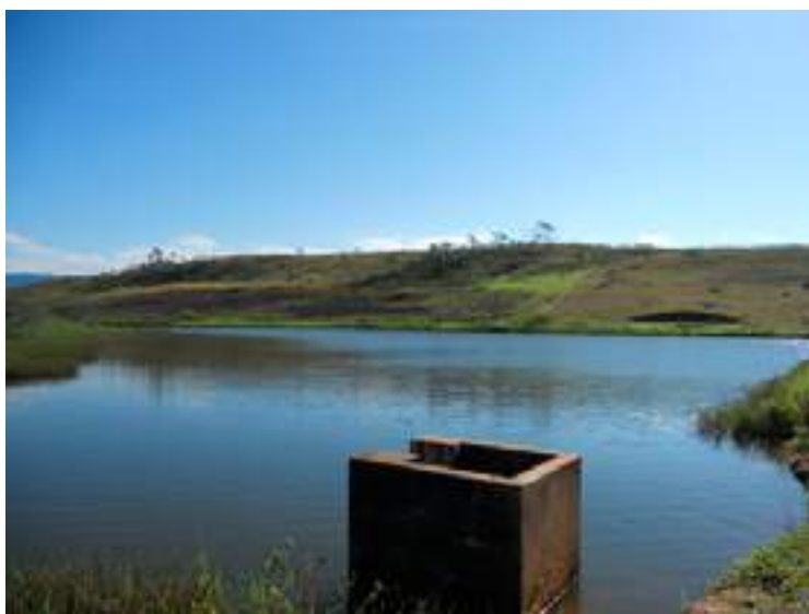
Figura 99. Um dos reservatórios previstos para implantação do projeto de piscicultura em tanques-rede – Assentamento Josué de Castro, Campos dos Goytacazes.
