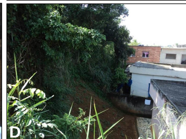
(A) Vista do talude aos fundos da moradia 306. (B) Densa vegetação no talude. (C) Pequena distância entre o talude e a moradia no setor de risco alto. (D) Depósito de escorregamento na base do talude.
