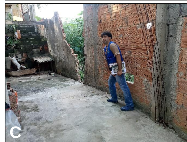
(A) Proximidade da moradia da base do talude; (B) Estrutura precária da moradia a montante do talude; (C) Muro embarrigado, trincas no terreno e na parede na moradia a montante; (D) Pequeno escorregamento na lateral da moradia.
