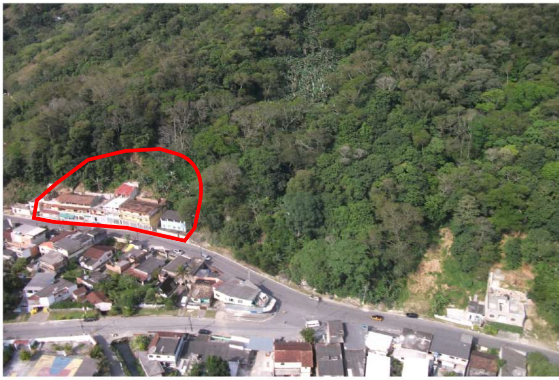
15 - Ma-GJ-077 - Rua João Marco
