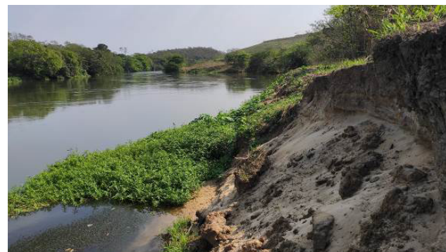
Imagem 1: Margem do Rio Guandu com processos erosivos em atividade.
