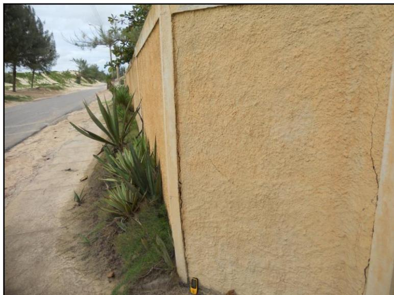
**FOTO 02: Rachaduras associadas ao solo de fundação (aterro mal compactado).**
