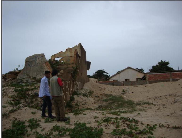
**FOTO 01: Edificação de quatro pavimentos que sofreu desabamento parcial devido a erosão marinha.**
