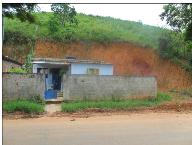
FOTO 3 - Foto do setor CMB-FM-26. As residências em questão encontram-se em risco iminente. O talude no qual margeia grande área da Rua Maria Julia Gomes, apresenta sulcos erosivos, assim como cicatrizes de escorregamento.
