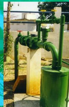
Foto 2 - Esquerda - Poço tubular profundo (Foto: Egmont Capucci)
